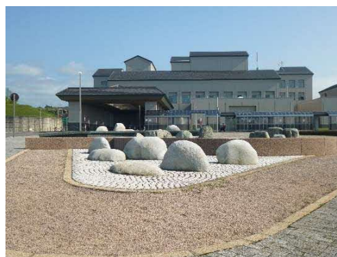
〈江差病院外観〉
