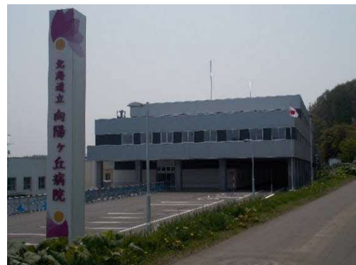
〈向陽ヶ丘病院外観〉
