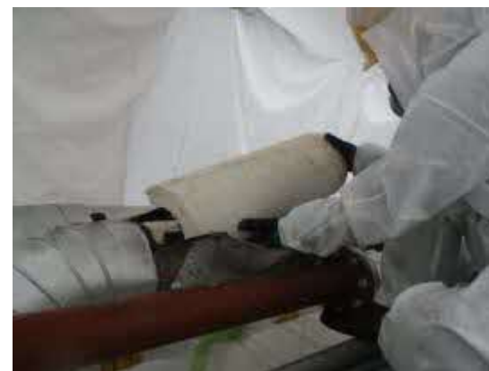
養生内で湿潤化後、手作業で除去
