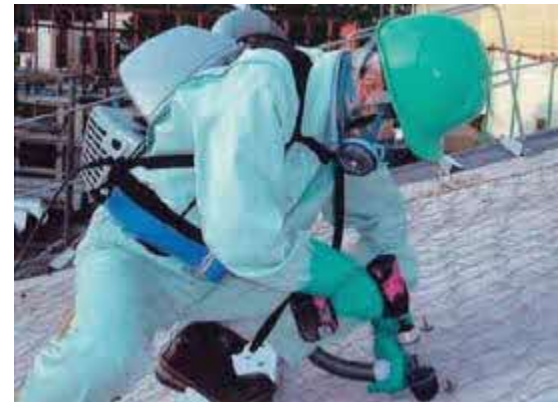
集じん回収（高性能真空掃除機）
