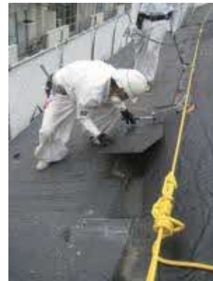
スレートの除去
