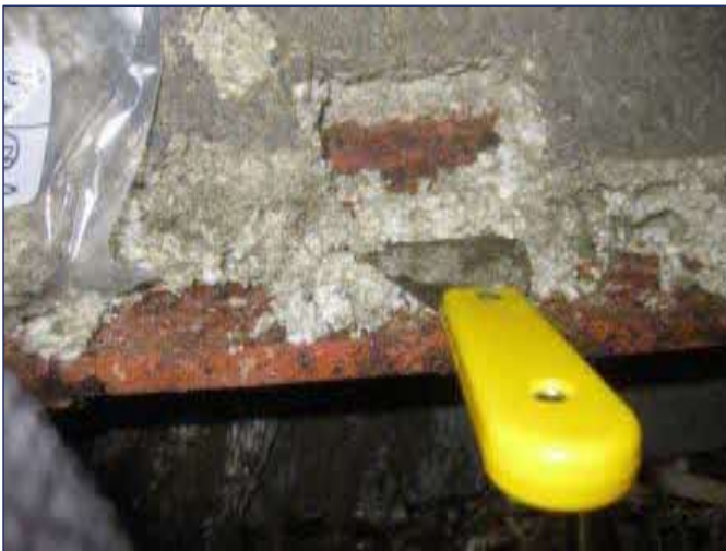
鉄骨吹き付け材
