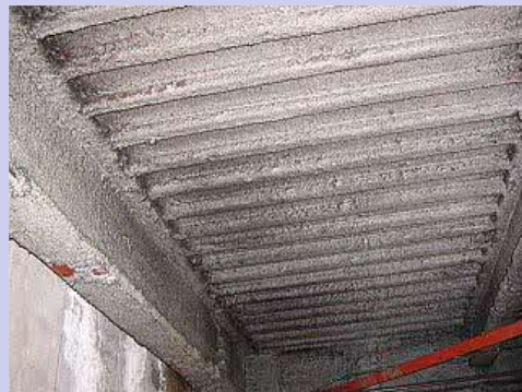
アスベスト含有吹付けロックウール (鉄骨材の耐火被覆)
