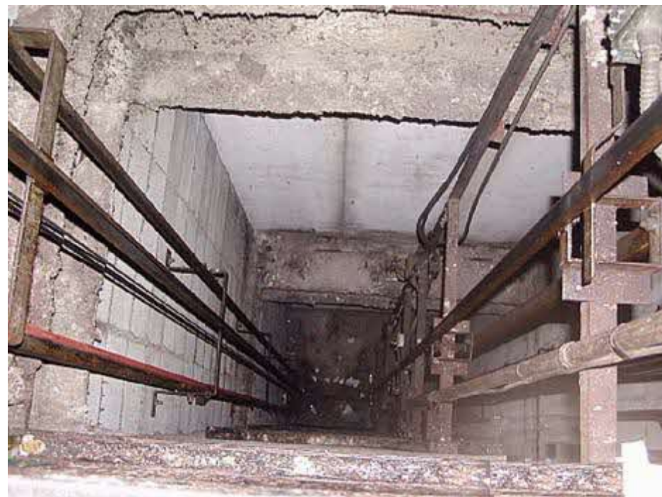
小荷物専用昇降機シャフト
