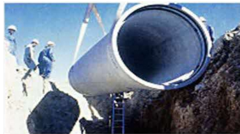
石綿セメント管
