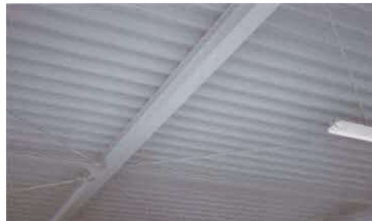
屋根用折版裏石綿断熱材
