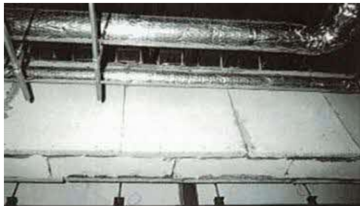
石綿含有ケイ酸カルシウム板 耐火被覆材
