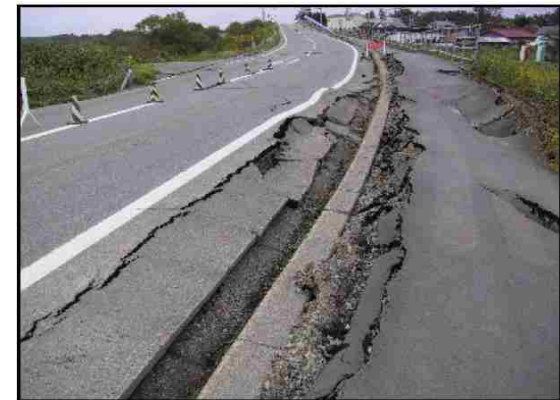
2003年十勝沖地震により亀裂や陥没が発生した道路(気象庁提供)
