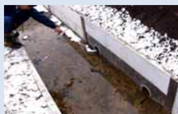
改修後の状況
