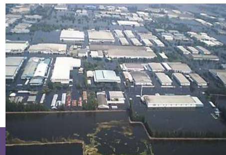
タイ ロジャナ工業団地の浸水状況 （2011年10月～11月）
