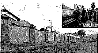
自主防災活動による畳堤設置 (摺保川水系、たつの市)
