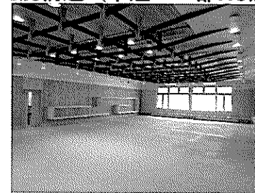
1階実習室:CLT特殊架構による大空間
