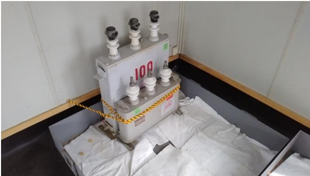
写真3：保管状況（コンデンサ：トレイ内）
