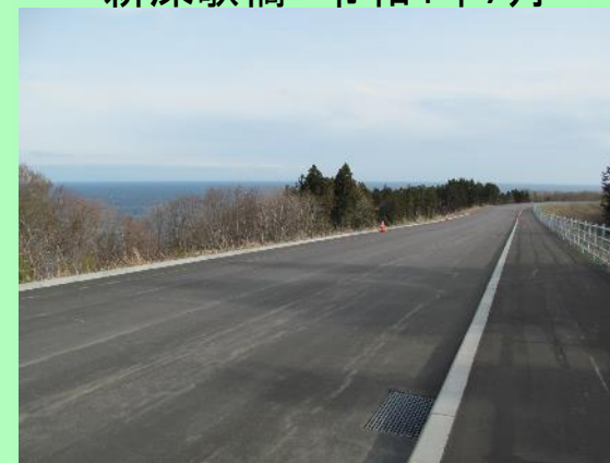
舗装工完了 令和4年4月
