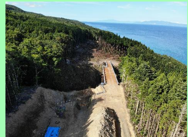
新兄力沢橋 令和4年6月
