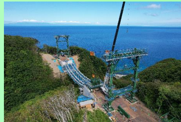
新深歌橋 令和4年7月
