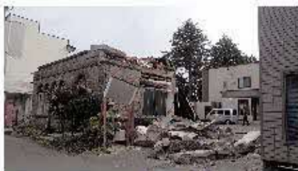
第36図 倒壊した石造家屋(安平町早来). Fig. 36 Collapsed masonry house at Hayakita, Abira Town.
