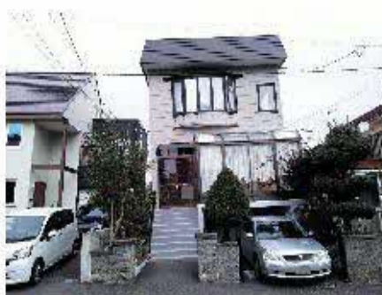
第30図 地盤沈下により傾動した家屋(清田地区)。 Fig. 30 The house tilted by subsidence at Kiyota area.
