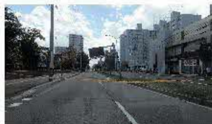
第34図 東区東15丁目屯田通における地盤沈下と、それにより傾動した標識(北27条東16丁目)。 Fig. 34 Subsidence and tilted road mark at Higashi 15-chome Tonden-street, Higashi-ku (kita 27-jo, higashi 16-chome).
