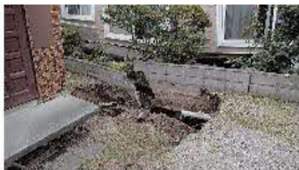
第13図 大曲川右岸, やや丘陵側に出現した地溝状亀裂群。 Fig. 13 Graven-like clacks at the hill-side, right bank of Omagari river.
