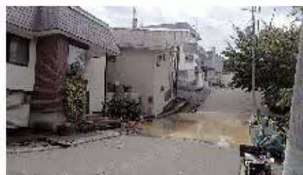
第20図 傾動した家屋と、沈下した地表に溜まった水(里塚北西部)。 Fig. 20 Tilted house and the pond at subsided ground surface at northwestern Satoduka area.
