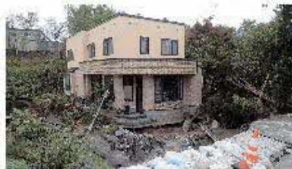
第14図 大曲川右岸, やや丘陵側に出現した地溝状亀裂群によって沈下, 水平移動した家屋。 Fig. 14 Subsided and horizontally migrated house on the graven-like clacks at the hill-side, right bank of Omagari river.
