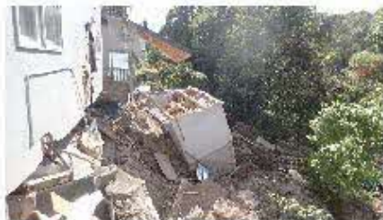
第11図 大曲川右岸で発生した斜面崩壊。 Fig. 11 Slope collapse at the right bank of Omagari river.
