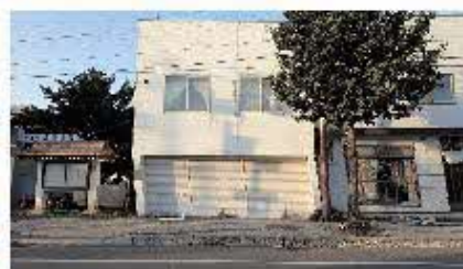
第44図 傾動した木造家屋(むかわ町花園). Fig. 44 Tilted wooden house at Hanazono, Mukawa Town.
