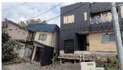
第21図 杭基礎施工された家屋では、家屋の傾動は認められない(里塚西北部)。
