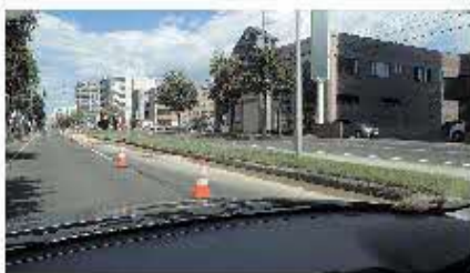
第33図 東区東15丁目屯田通における噴砂と地盤沈下(北20条東16丁目)。 Fig. 33 Sand boil and subsidence at Higashi 15-chome Tonden-street, Higashi-ku (kita 20-jo, higashi 16-chome).
