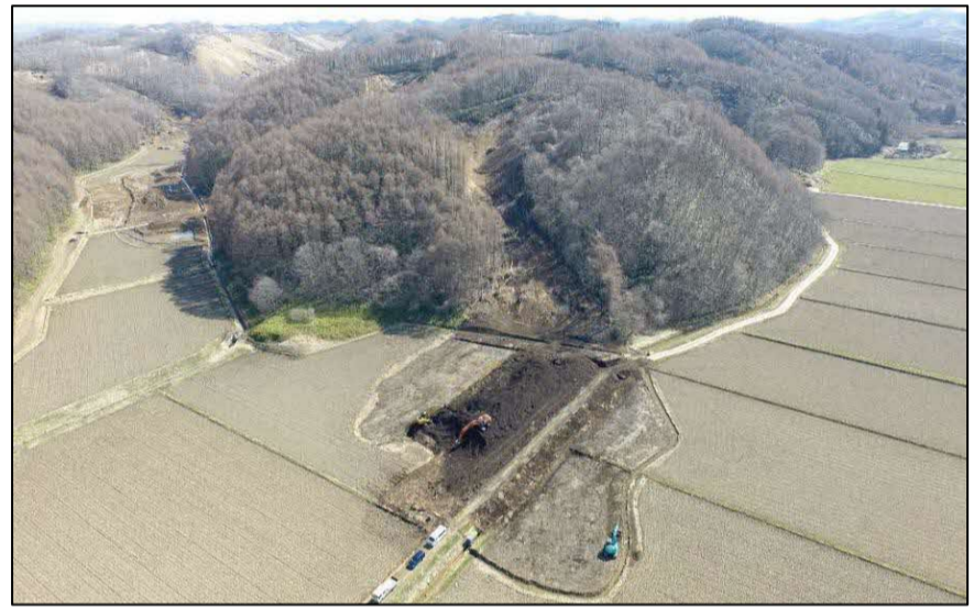
堆積土砂をほ場内に片寄せ(平成31年4月撮影)
