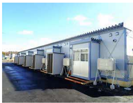
風除室、灯油タンク、外部物置
