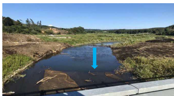
平成30年9月11日埋塞土砂の除去作業完了
