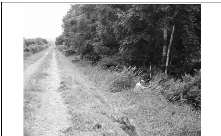
左岸② 写真2 撮影方向：堤防から撮影（下流方向）
