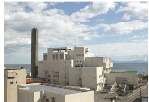
老朽化した焼却施設（函館市）
