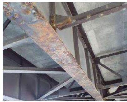
錦岡跨線橋（苫小牧市）
