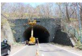
コンクリートのうき（坑門）、照明の腐食等を確認
