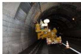
コンクリートのうき（坑門）、照明の腐食等を確認
