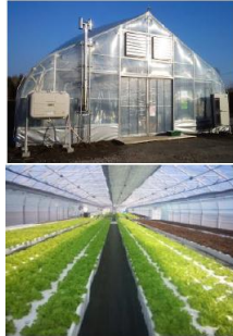
複層ビニールハウス
