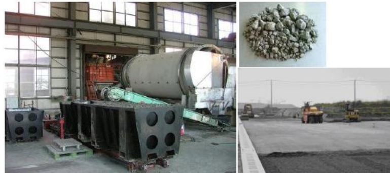
リサイクル路盤材の製造過程
