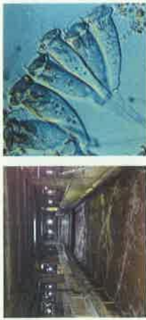
▲反応タンク: 空気を送りこみ、微生物を活動させています
