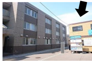
寮の駐車場に工事関係者用のプレハブが設置されています
