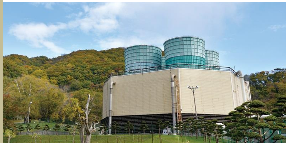
北海道電力網森発電所（森町。1982年運転開始。出典：JOGMEC（独立行政法人石油天然ガス・金属鉱物資源機構）のホームページ）
