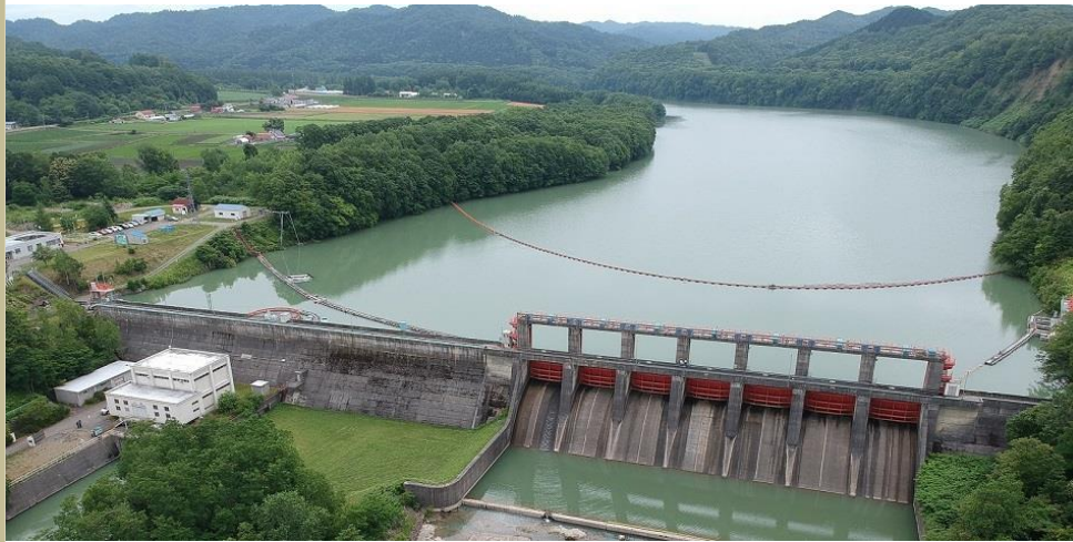
北海道企業局川端発電所（栗山町）。1962年運転開始。年間発電電力量は、一般家庭約5,600戸分（令和2年度実績）。出典：北海道企業局ホームページ
