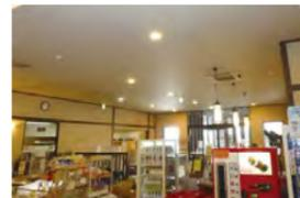
全体的に省エネを考慮して間引き点灯をしているものの、明るさのコントラストがでてしまい、均斉度が下がっています。お客様が入場した際、全体的に薄暗い印象を受けてしまうため、LED照明で間引き前の設計照度まで戻した方が、印象が良くなります。
