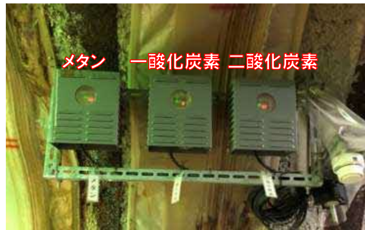
地下の環境を監視するセンサー
