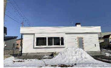
空き家対策事業による改修物件の様子
