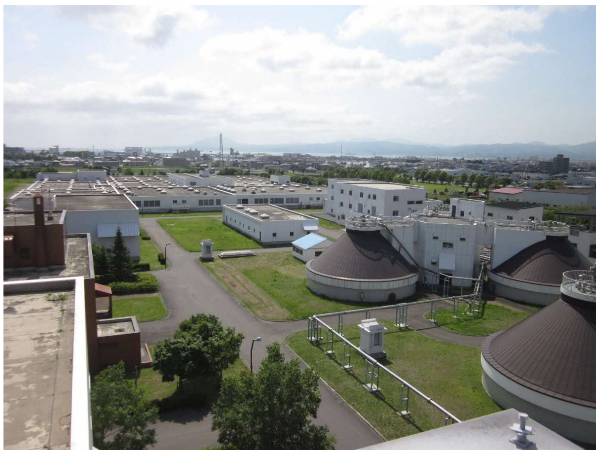
函館湾流域下水道函館湾浄化センター全景
