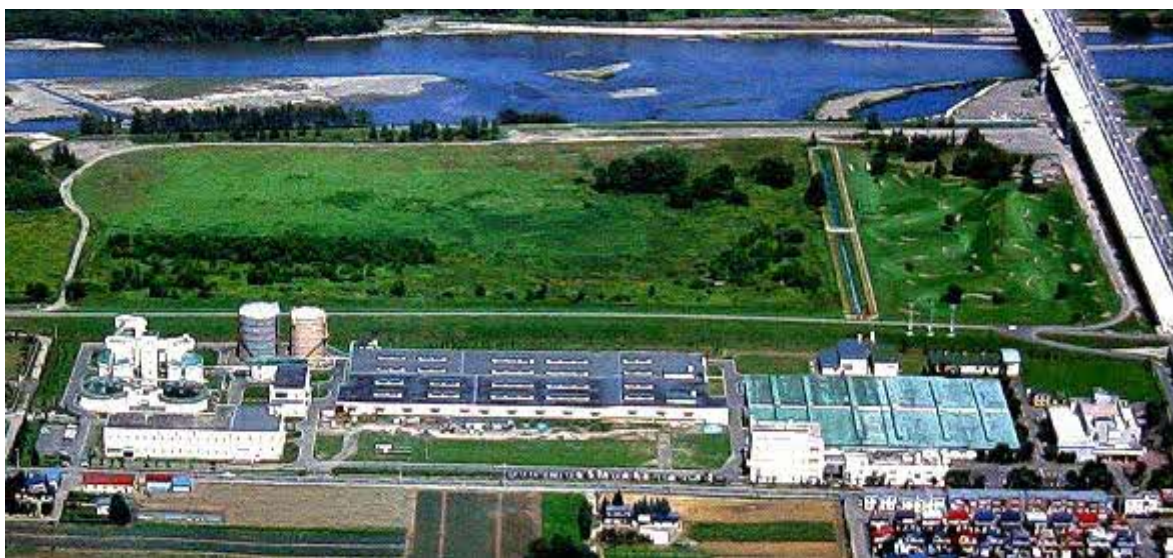
十勝川流域下水道十勝川浄化センター全景
