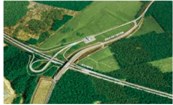
新千岁机场高速出入口
