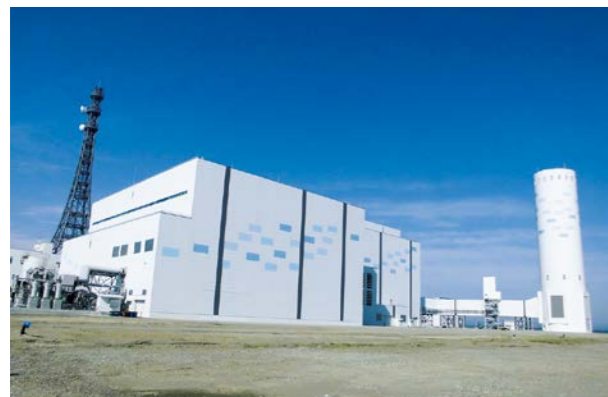
石狩湾新港发电厂(LNG火力发电厂)
