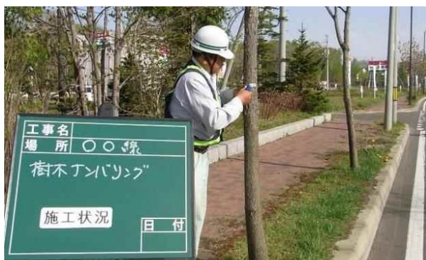
ナンバーリング施工状況
