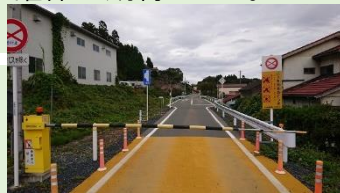
交差点(専用道側の遮断機)【大船渡線BRT】
