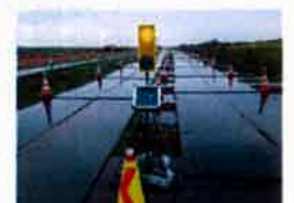
(例) 工事現場でのソーラーパネルの活用
