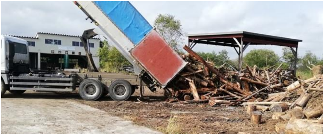
図 27 中間土場での荷降ろし
