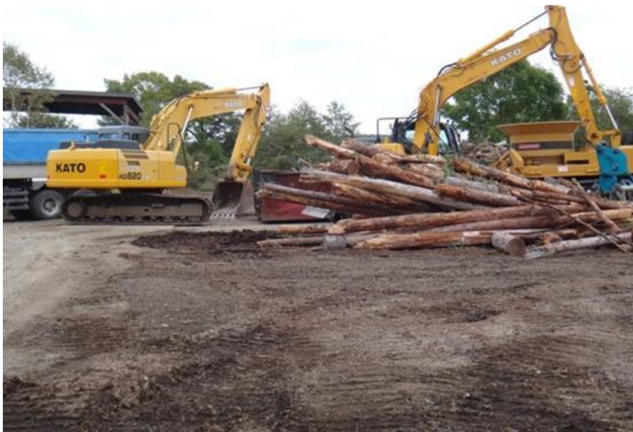
図 31 中間土場の状況
