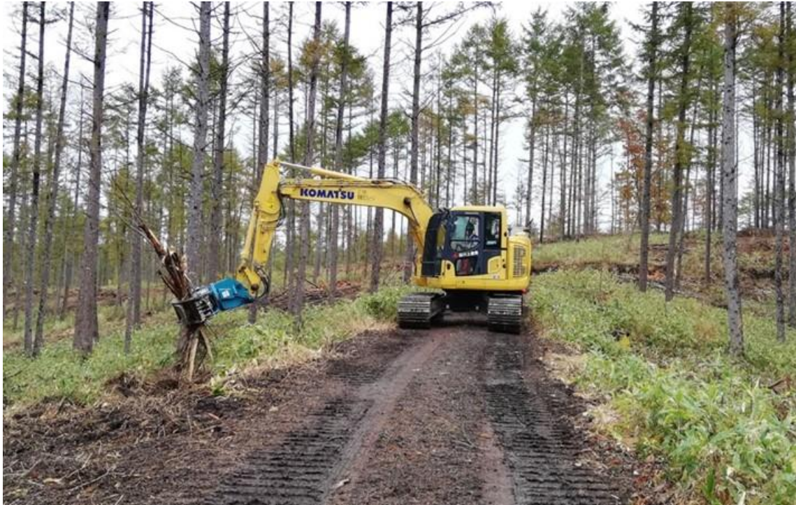
図 13 林地未利用材の断割
