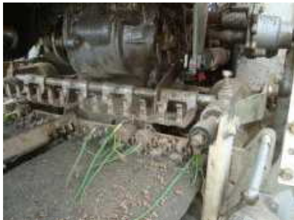
ポットの崩壊状況 (H26. 5. 2)
