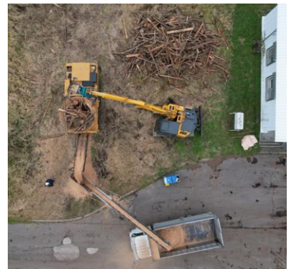
検証作業の様子
