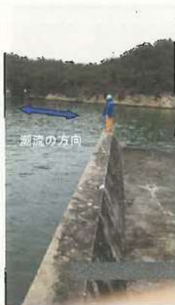
水処理施設前の突堤先端
