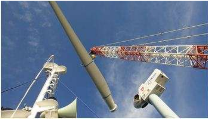
風車のブレード取り付け状況
