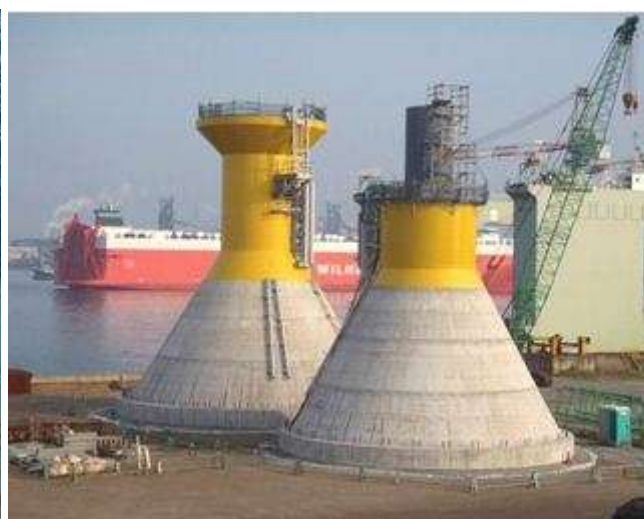
完成した風車、観測タワーケーソン基礎
