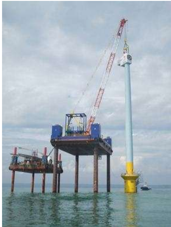
風車のナセル取り付け
