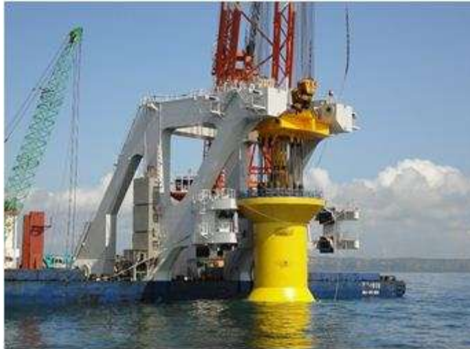
銚子沖の風車ケーソン基礎据付状況
