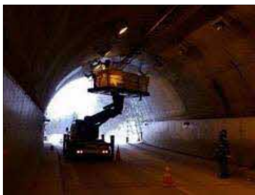
道路トンネル点検
