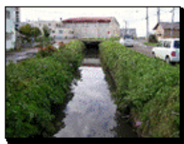
下水道整備後の河川
