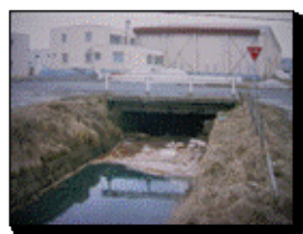
下水道整備前の河川
