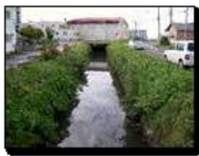
下水道整備後の河川
