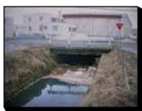
下水道整備前の河川
