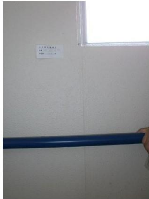
ひび割れ計測X22-Yc4付近(階段内壁)
