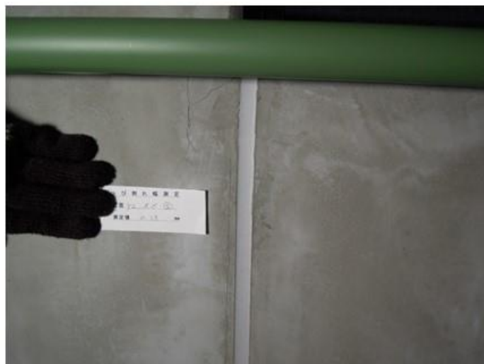
ひび割れ計測Y2通-X6付近(廊下内壁)
