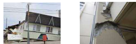
【H30年度北海道胆振東部地震 被害状況写真】
