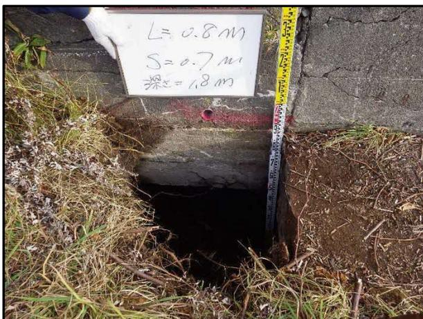
天端被覆工の陥没
