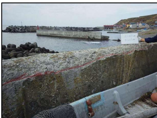
波返工の剥離・損傷
