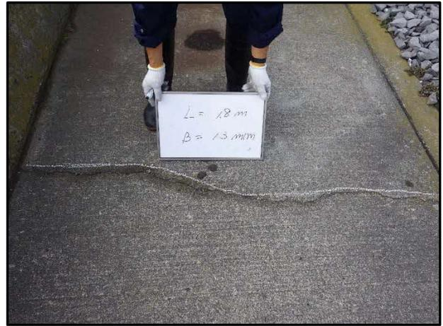
天端被覆工のひび割れ
