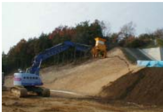
図 - 3.6 撒きだし工
