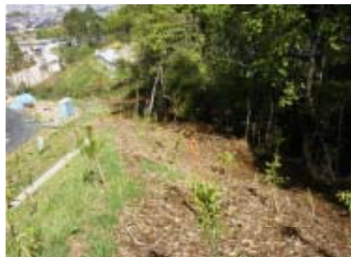
図 - 3.2 法面肩部のマルチング状況
