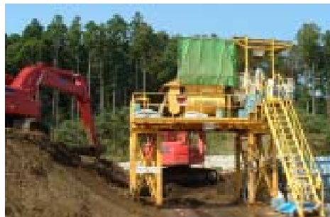
図 - 3.5 生育基盤材料の製造工
