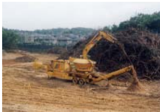
図 - 3.1 伐採木の破碎状況
