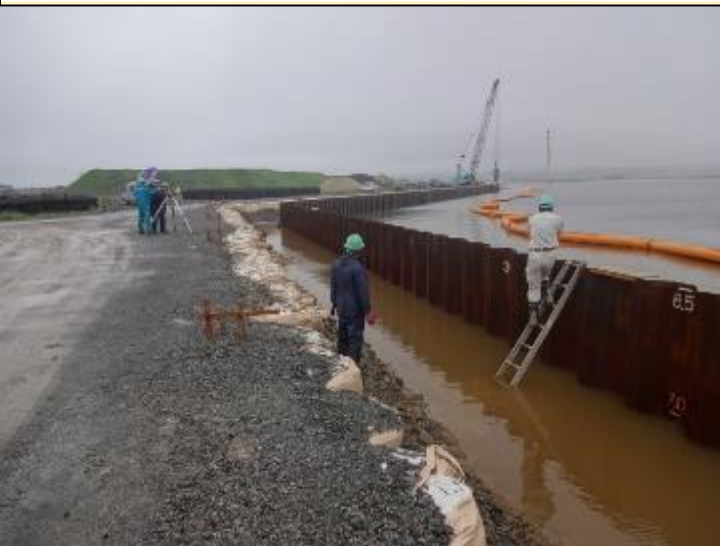
担当した施設災害復旧工事（護岸工）
