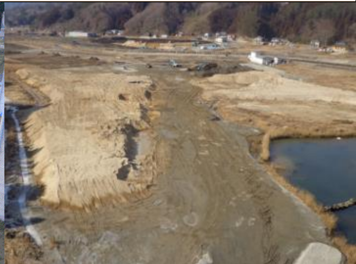
復旧工事の状況
