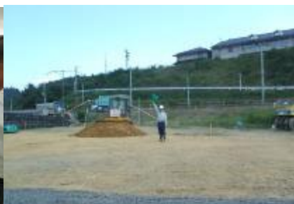
戸倉地区海岸 復旧工事着工式
