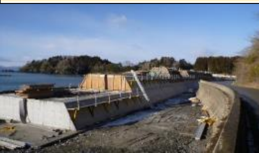
館浜地区海岸 防潮堤工事現場
