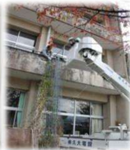
みどりのカーテン撤去作業
