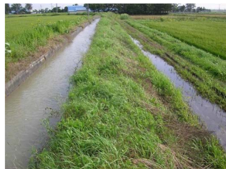
用水路からの漏水で隣接農地が湿害
