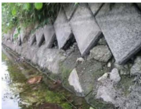
積ブロック水路の老朽化状況
