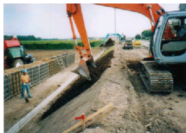
②法覆基材施工
