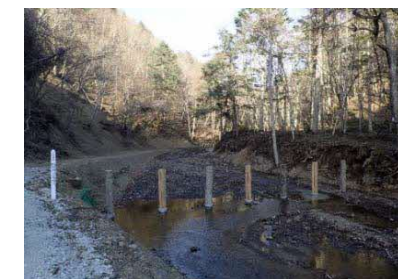
木製流木捕捉工
