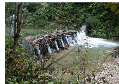
流木捕捉式治山ダム
