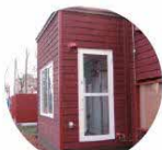
水素燃料電池格納施設
