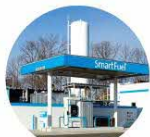
水素ステーション
